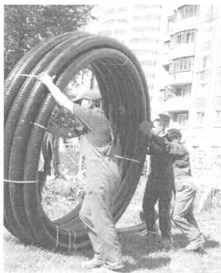
Рисунок 4.3 – Размотка ГПИ-труб, поставляемых в бухтах
